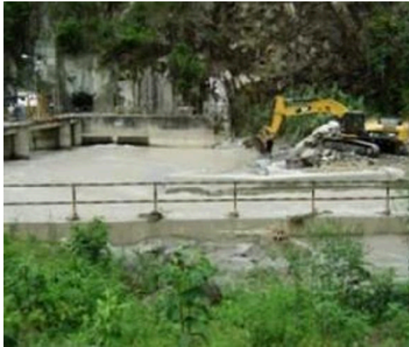
Limpieza de material sedimentado – Bocatoma
