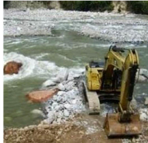
Descolmatación de río Tulumayo
